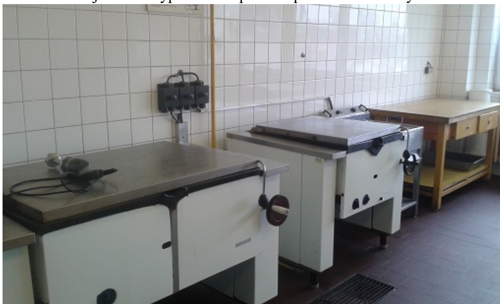
Obr. č.3 Žlab je mimo vypouštění z pánve a pohled na dřevěný stůl ve varně
